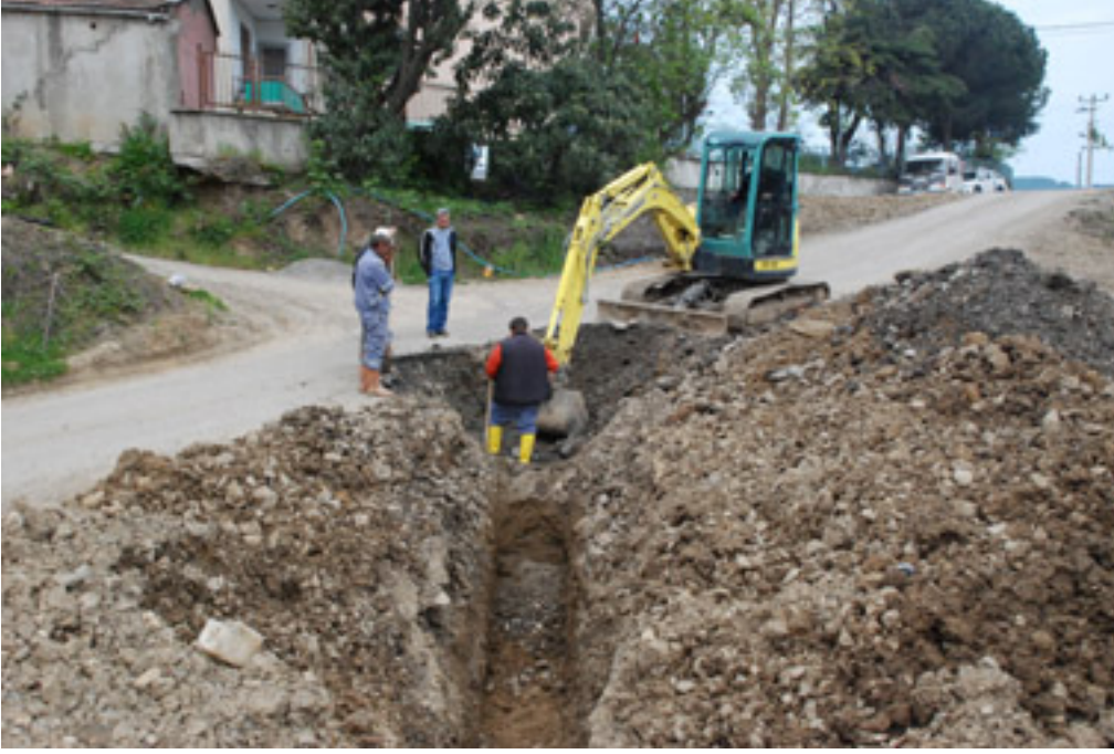
Fatsa Belediyesi alt yapı çalışmalarını ilçenin değişik yerlerinde sürüyor.
