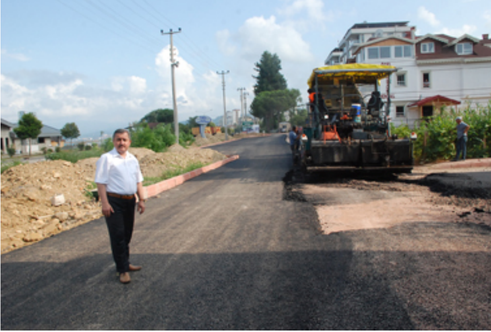
Fatsa Belediye Başkanı Hüseyin Anlayan, Dolunay Mahallesi'nde devam eden asfalt çalışmalarını yerinde inceledi.
